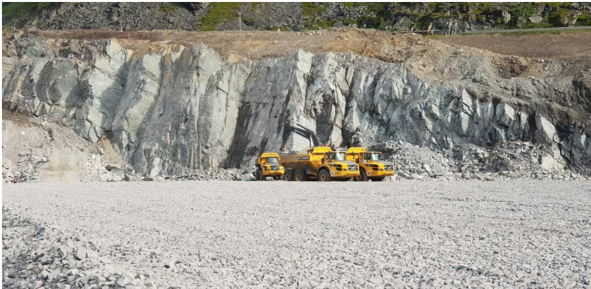
Anleggsarbeider Leirvika prosjektet. Foto: Hammerfest Havn KF
