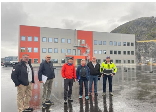
Overlevering av logistikk-bygg i Leirvika
