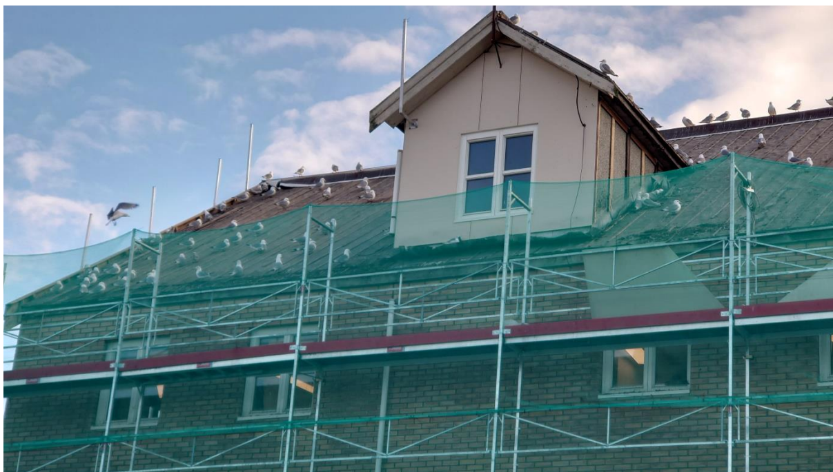
Renovering av Bibliotektaket
