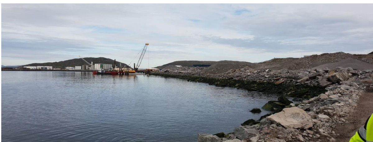
Anleggsarbeider Leirvika prosjektet. Foto: Hammerfest Havn KF
