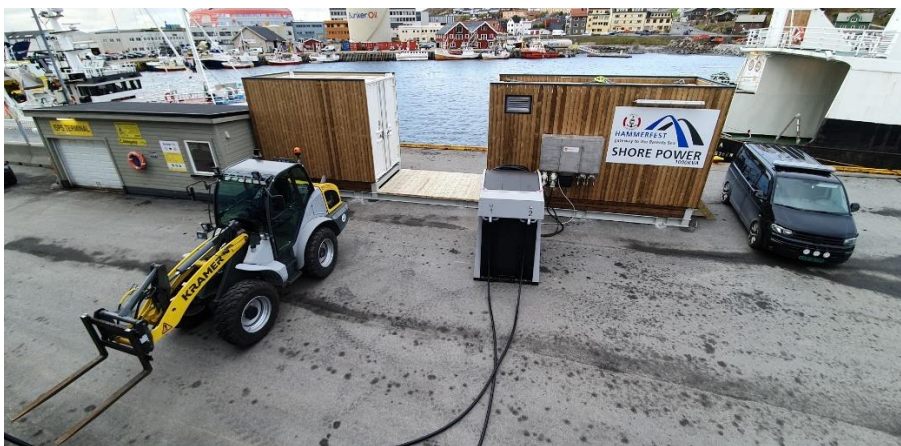
Miljøsatsing, landstrømsanlegg ved våre kaier. Foto: Hammerfest Havn KF
