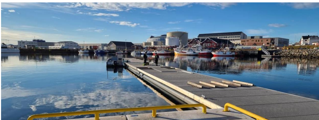
Utlekking av flytemolo og marinaanlegg på Fuglenes. Foto: Hammerfest Havn KF
