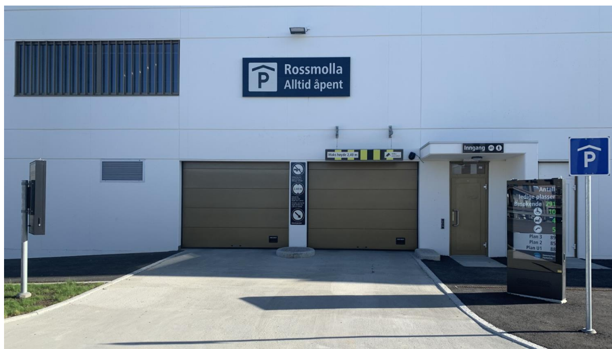
Parkeringshus ferdigstilt ved nye Hammerfest Sykehus
