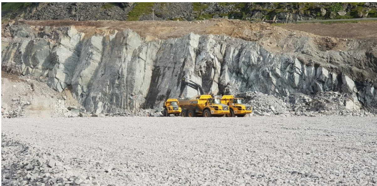
Anleggsarbeider Leirvika prosjektet. Foto: Hammerfest Havn KF
