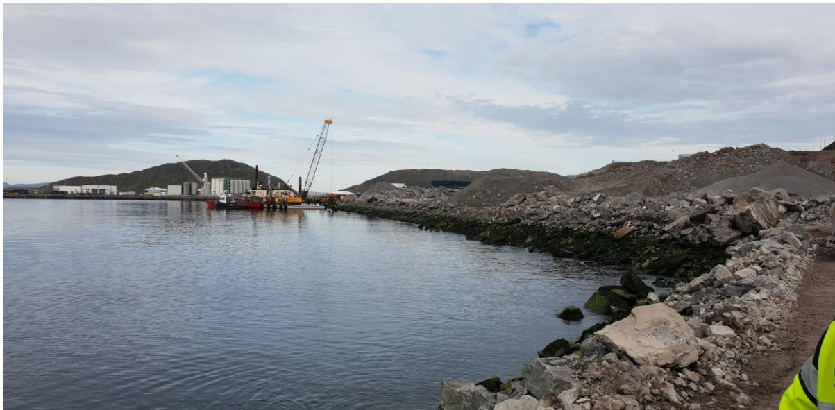
Anleggsarbeider Leirvika prosjektet. Foto: Hammerfest Havn KF
